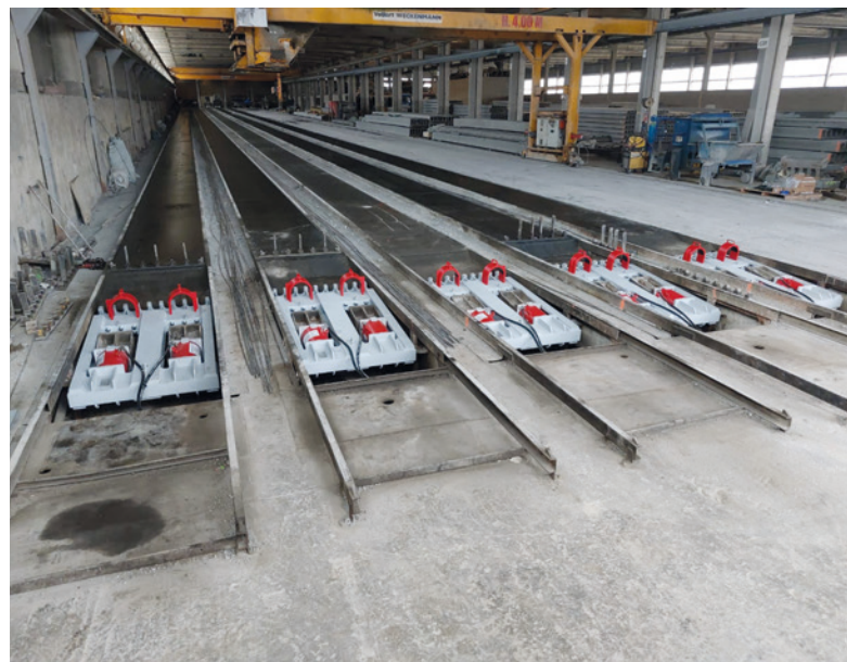
Nuove travi di reazione con sistema di rilassamento
