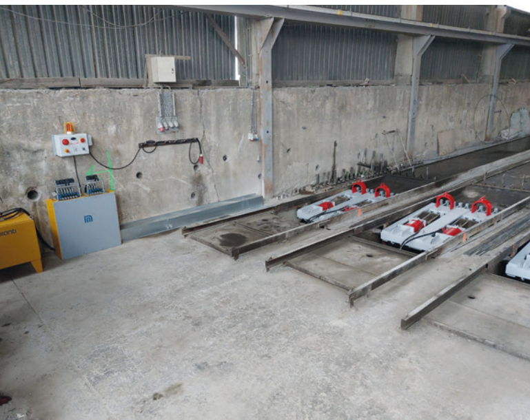
Nuovo sistema di rilassamento con centralina di rilassamento fissa
